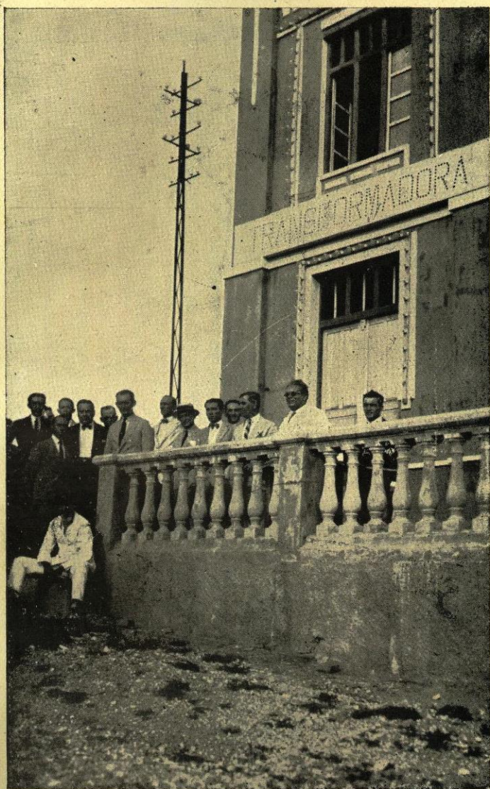
Usina Transformadora CUIABÁ — MATTO-GROSSO
